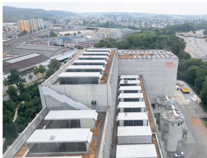
Blick auf die Prozessgebäude der Kehrrechtverwertungsanlage (hoher Teil links) und auf das Holzheizkraftwerk (rechts) sowie die beiden Silos für Holzschnitzel.
